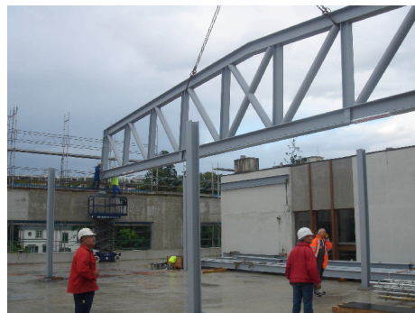
Poutres métalliques principales suspendant les planchers
