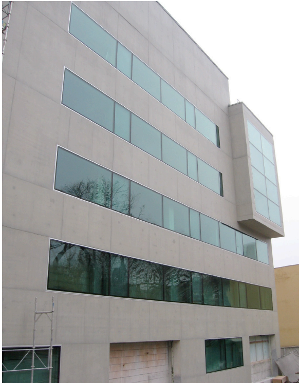
Façade en béton apparent contenant l'ancien bâtiment
